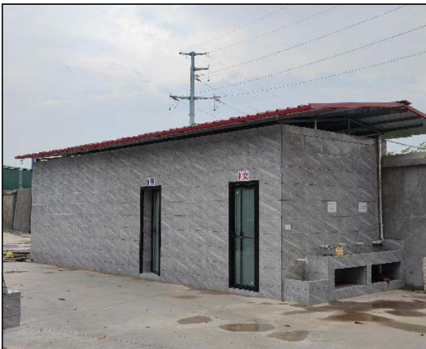
项目共用卫生间及化粪池
