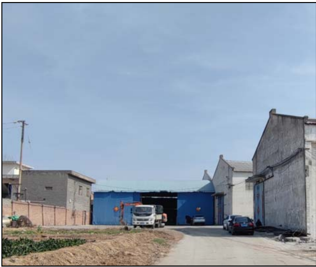
本项目车间现状
