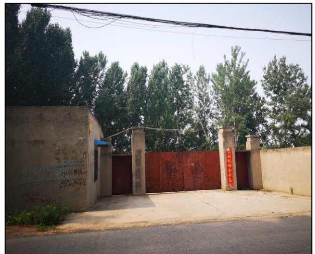
项目西侧空置厂区
